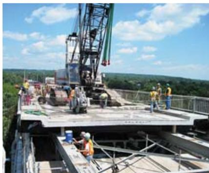
El uso de equipo de elevación móvil y ligero para el reemplazo del tablero del puente Princess Margaret, en Nuevo Brunswick, nos permitió evitar reforzar el puente para que soportara grúas más pesadas.
