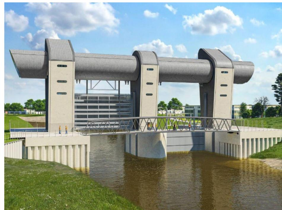
fournir la répartition détaillée du carbone dans chaque matériau de construction utilisé. La Société s'est rapidement aperçue que les pieux de béton armé à coffrage d'acier proposés contribuaient à plus de 25 % du carbone intrinsèque total du concept. En passant à des tubes d'acier battus, tout en améliorant d'autres aspects de la conception, y compris l'utilisation de barrières en béton préfabriqué, l'équipe de projet a pu dépasser les objectifs de réduction du carbone intrinsèque.
